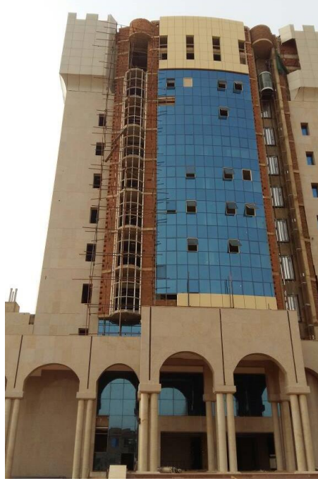
شكل (٣١) يوضح الواجهة أثناء تركيب المواد عليها
