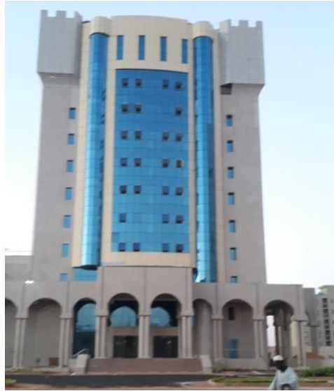
شكل (٢٨) يوضح عدم استخدام الأشجار بالصورة المطلوبه
