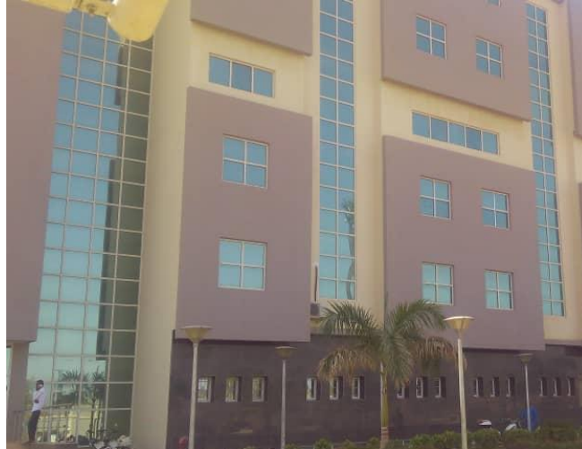
شكل (٢١) يوضح دهن الحوائط الخارجية لمبنى الأدلة الجنائية
