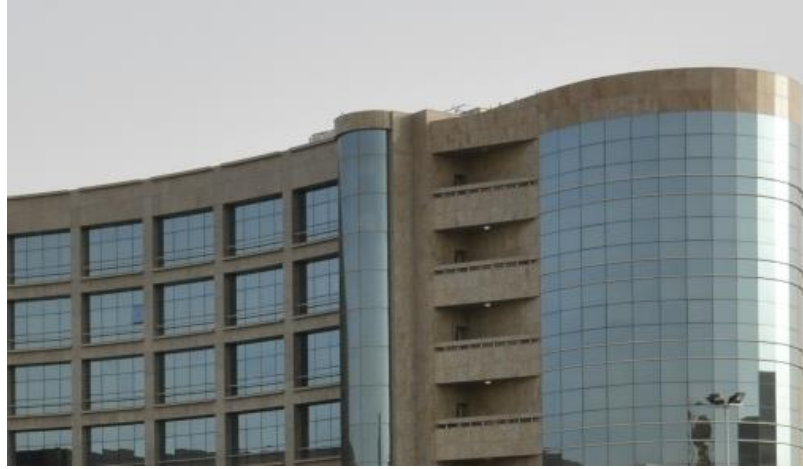
شكل (٣٥) يوضح استخدام الزجاج في الواجهات
